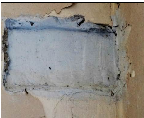
Nejedlého 6 – Stávající sádrová plotna na schodišti
