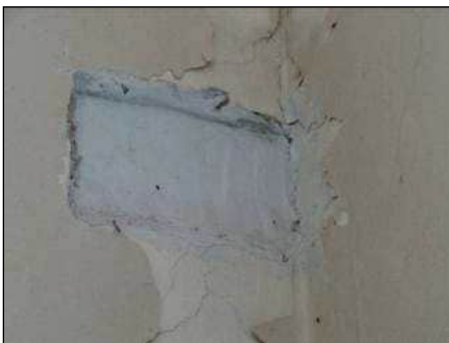
Nejedlého 6 – Stávající sádrová plotna na schodišti
