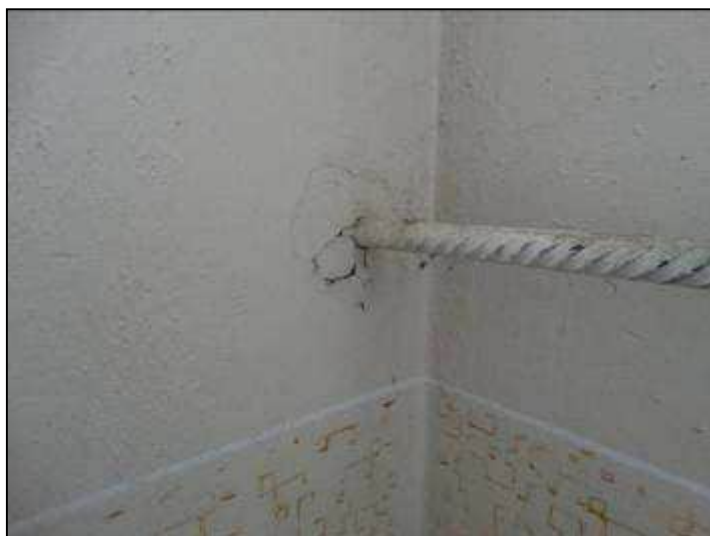
Nejedlého 2 – Průchod spínacího táhla stěnou na schodišti
