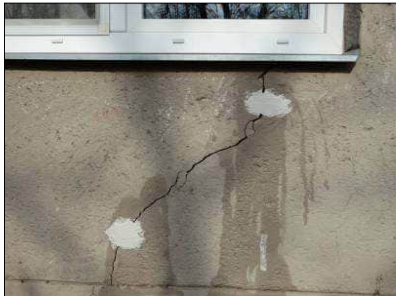
Nové sádrové terče umístěné pod oknem u jihozápadního nároží
