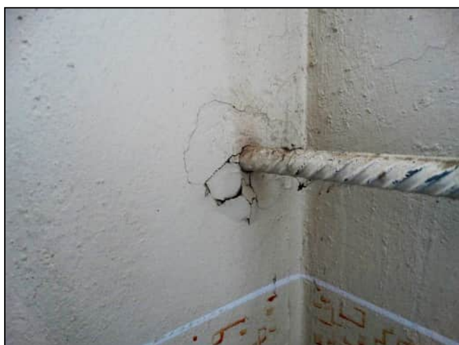
Nejedlého 2 - Průchod spínacího táhla stěnou na schodišti
