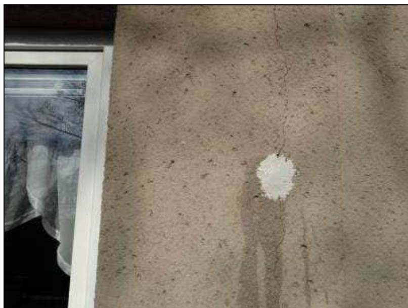
Nový sádrový terč vedle okna u jihozápadního nároží domu
