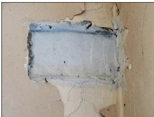
Nejedlého 6 – Stávající sádrová plotna na schodišti
