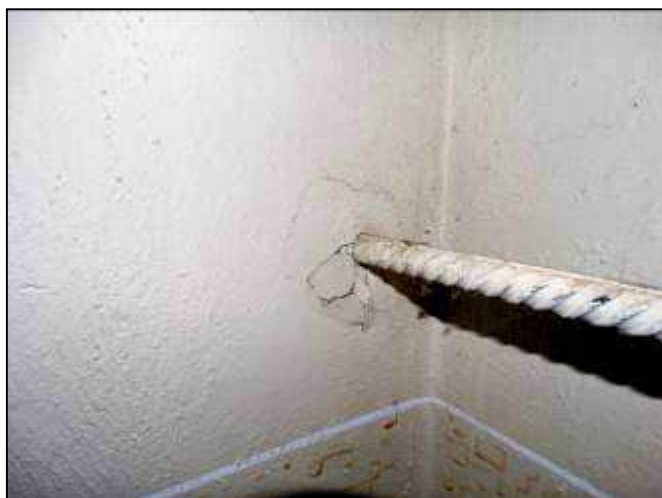
Nejedlého 2 - Průchod spínacího táhla stěnou na schodišti
