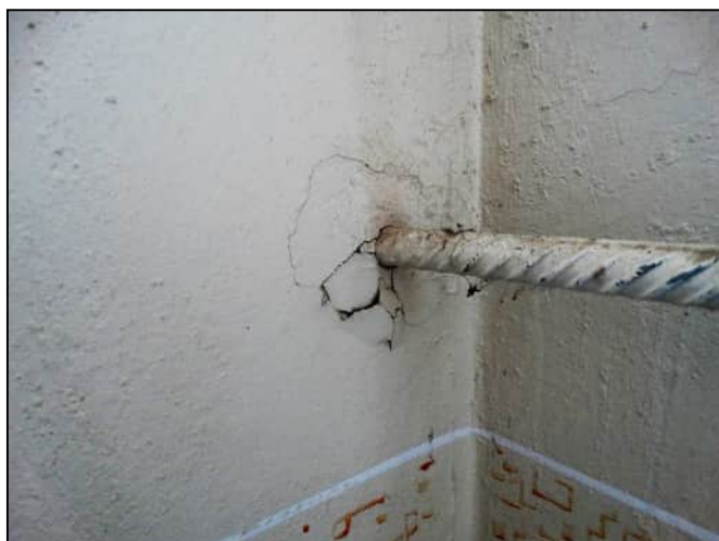
Nejedlého 2 - Průchod spínacího táhla stěnou na schodišti
