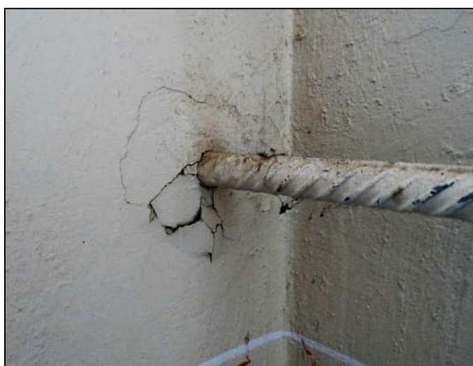
Nejedlého 2 - Průchod spínacího táhla stěnou na schodišti
