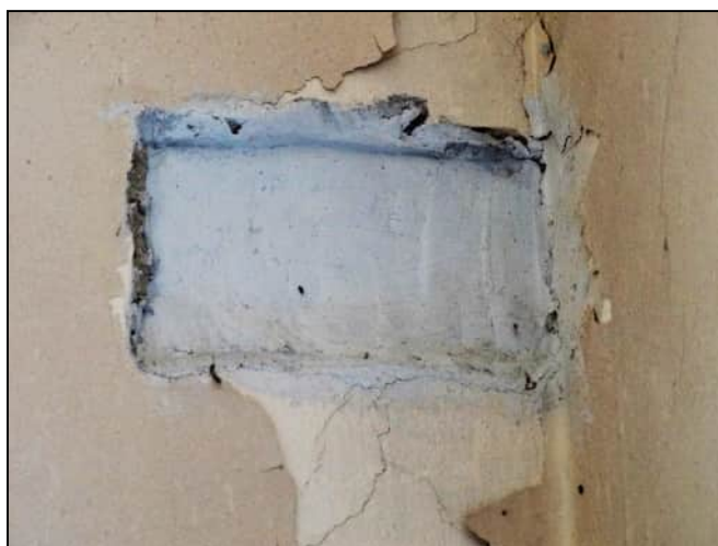
Nejedlého 6 – Stávající sádrová plotna na schodišti
