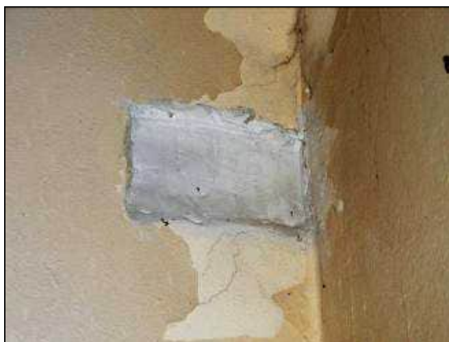
Nejedlého 6 – Stávající sádrová plotna na schodišti
